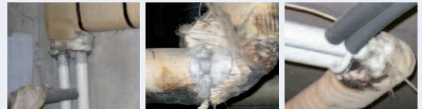
Figure 15 : Exemples de calorifuges non satisfaisants
