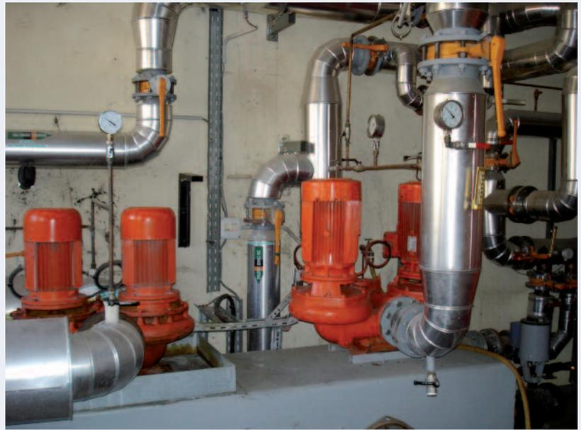
Figure 24 : Vue des pompes de distribution en sous-station
