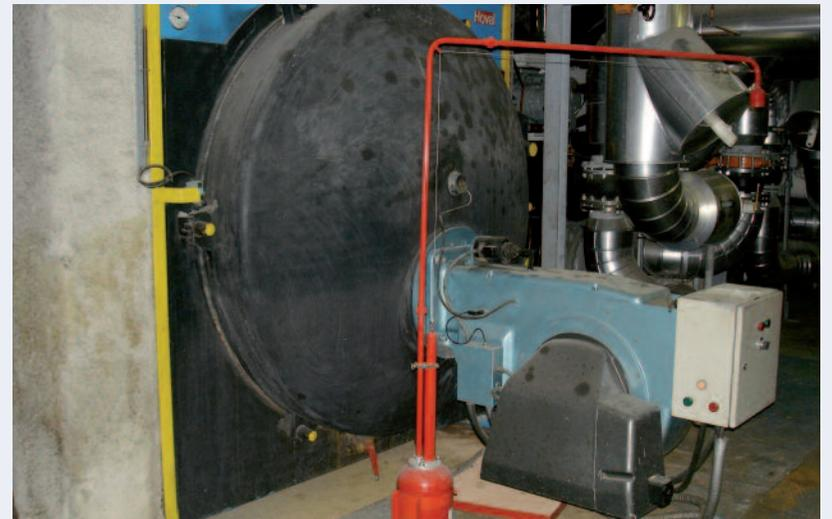
Figure 22 : Vue d'une des deux chaudières fioul
