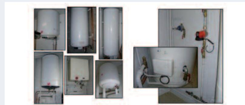
Figure 34 : Les 6 ballons petites et moyennes capacités - le ballon 500 l et son bouclage
