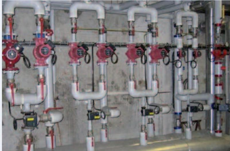
Figure 14 : Nourrice générale et panoplie des 5 circuits de chauffage
