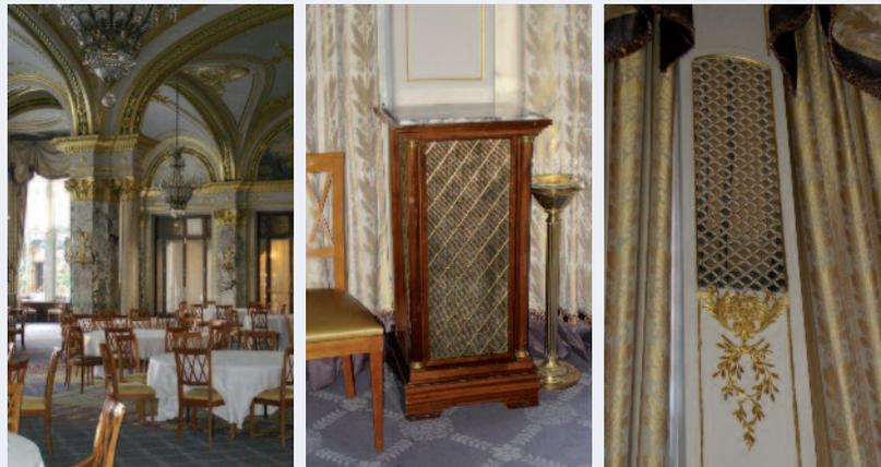
Figure 27 : Vues de la salle Empire et des dispositifs de soufflage/reprise d'air (côté zone vitrée)
