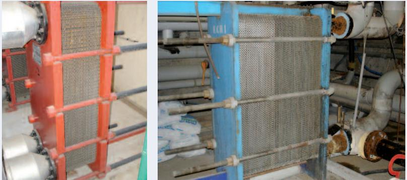
Figure 23 : Vues des échangeurs des circuits eau chaude et eau glacée de la sous-station
