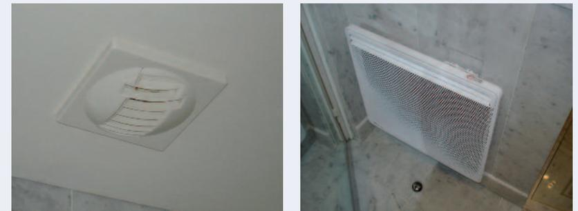
Figure 32 : Vues des équipements des salles de bain :VMC et rayonnant électrique
