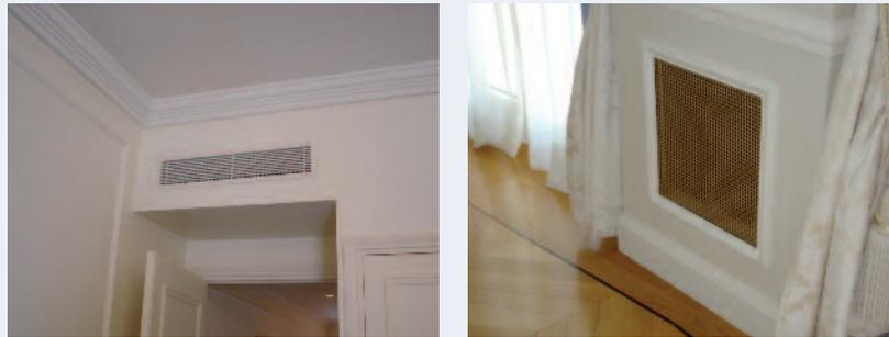
Figure 30 : Vues d'une grille de soufflage et d'une grille de reprise
