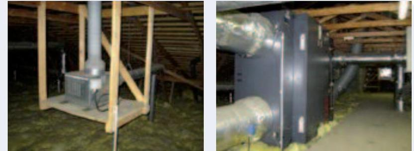
Figure 35 : Vue des caissons d'extraction et de la Centrale de Traitement d'Air
